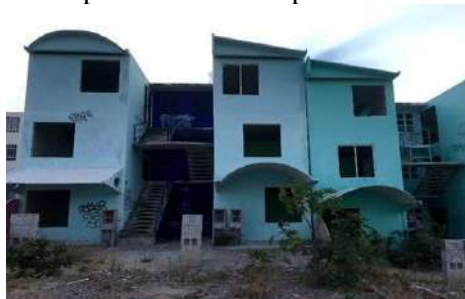
Figura 3. Departamentos en espera de ser demolidos
